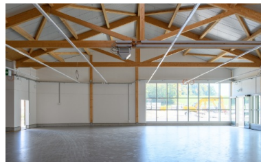
Sichtbare Holzkonstruktion im Innern
