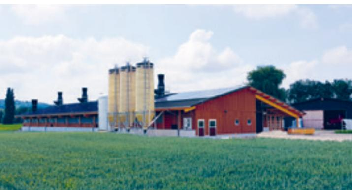
La halle d'engraissement de poulets à Kallnach a été construite en cinq jours, et ce, malgré un espace restreint de 67 m de longueur par 25 m de largeur et une surface utile de 1200 m<sup>2</sup>. L'enveloppe de bâtiment conçue en panneaux sandwich est dotée d'un revêtement imprégné sous pression en bois d'épicéa. Le concept sur mesure a été conçu et réalisé par notre partenaire Globogal SA.
