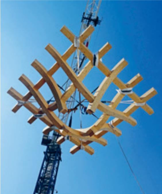
de construction en bois s'est chargée de l'élaboration des plans détaillés de prémontage, de montage ainsi que des données de production. Les six lucarnes à double sens conçues comme des Free Form sont particulièrement visibles dans la structure du bâtiment. Lors de la conception, l'assemblage de la construction en bois avec les nombreuses façades vitrées a été un défi.
