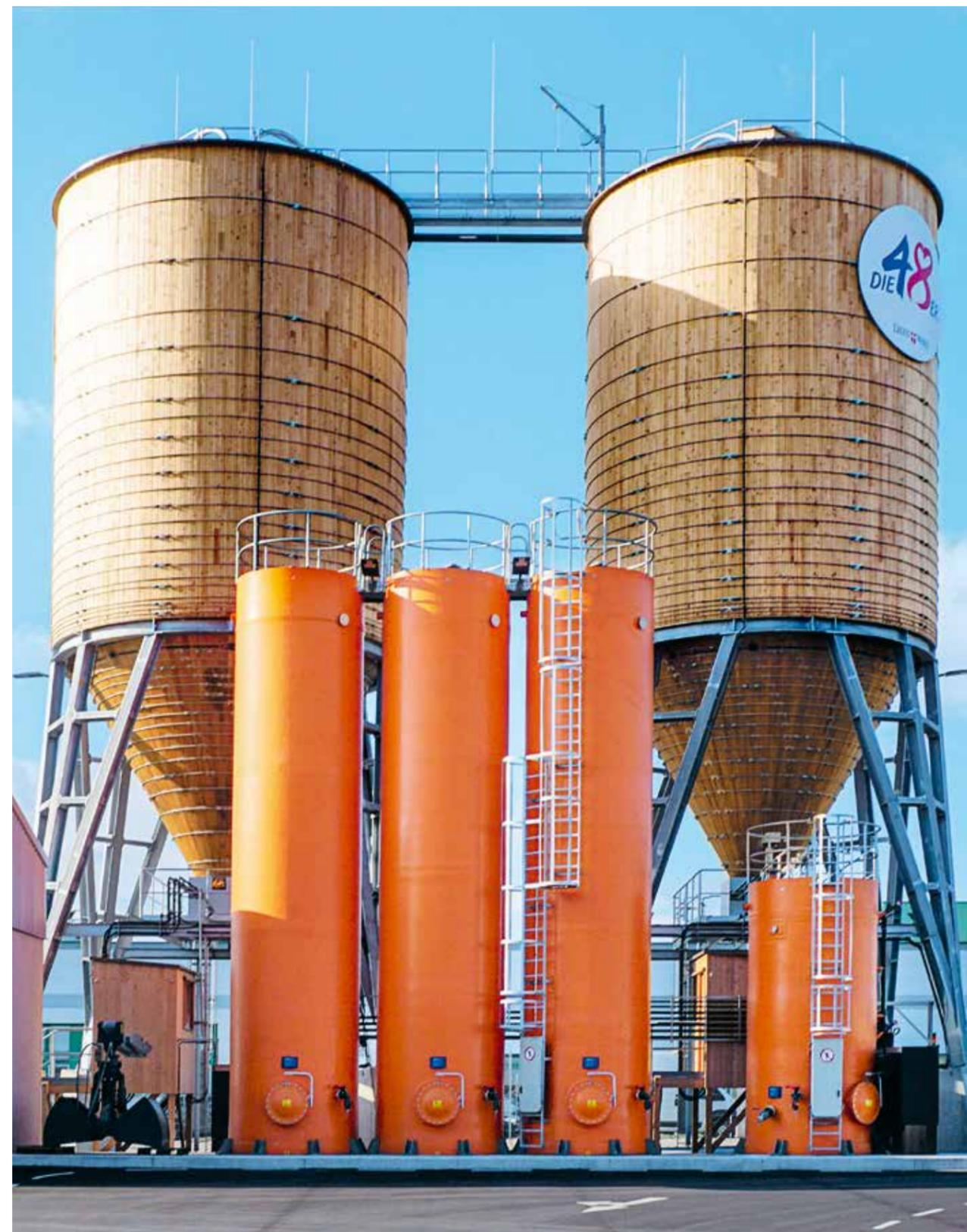
Vienne (AT), silos ronds 2 x 500 m<sup>3</sup> et réservoirs de stockage de saumure 3 x 45 m<sup>3</sup> avec installation de production de saumure.
