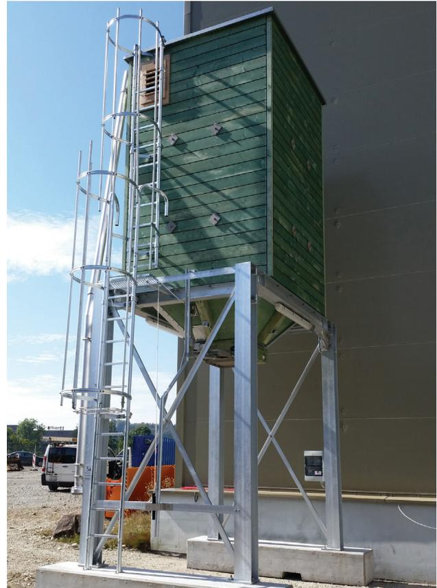
Der Kleinsilo auf verbreitertem Stahlunterbau wurde mit feuerverzinkter Aufstiegsleiter erstellt. Die mitgelieferten mobilen Fundamente ermöglichen eine kurze Montagezeit und eine flexible Standortplanung.
