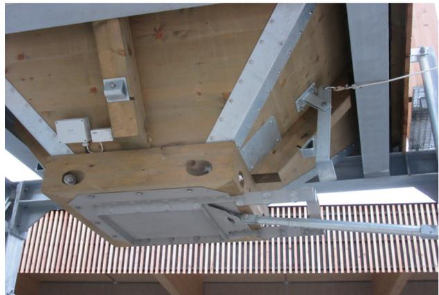
Der Salzsilo auf kubischem Stahlunterbau wurde mit einer vertikalen Lärchenfassade ausgeführt. Die verbreiterte Durchfahrt ermöglicht einen Salzbezug auch mit grösseren Streufahrzeugen. Das Gefälle der Bodenplatte wurde bei der Planung und Ausführung des feuerverzinkten Stahlunterbaus berücksichtigt.
