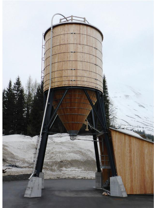
Normsiloplanlage auf duplexiertem Stahlunterbau mit Y-Stützen. Das Fass und der Zylinder sind in Lärchenholz gefertigt. Dies garantiert eine lange Lebensdauer und ein Minimum an Unterhaltskosten.
