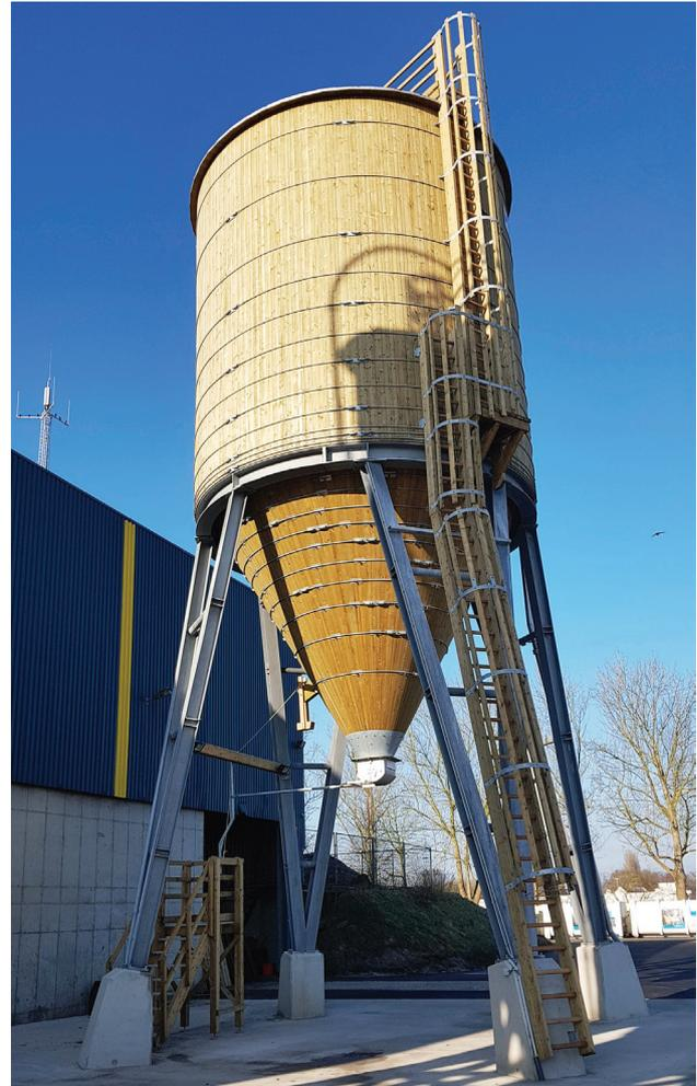
Dieser runde Silo aus Fichtenholz ist auf feuerverzinktem Stahlunterbau in V-Form errichtet.
