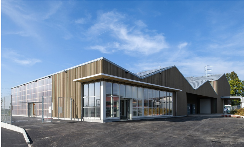
Entrée avec façade vitrée
